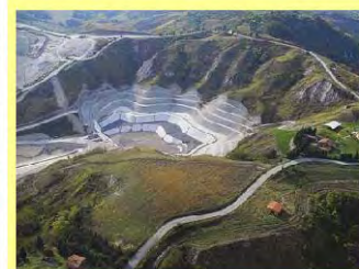
Station de traitement des déchets située dans la municipalité de Pecchioli (Toscane, Italie)
