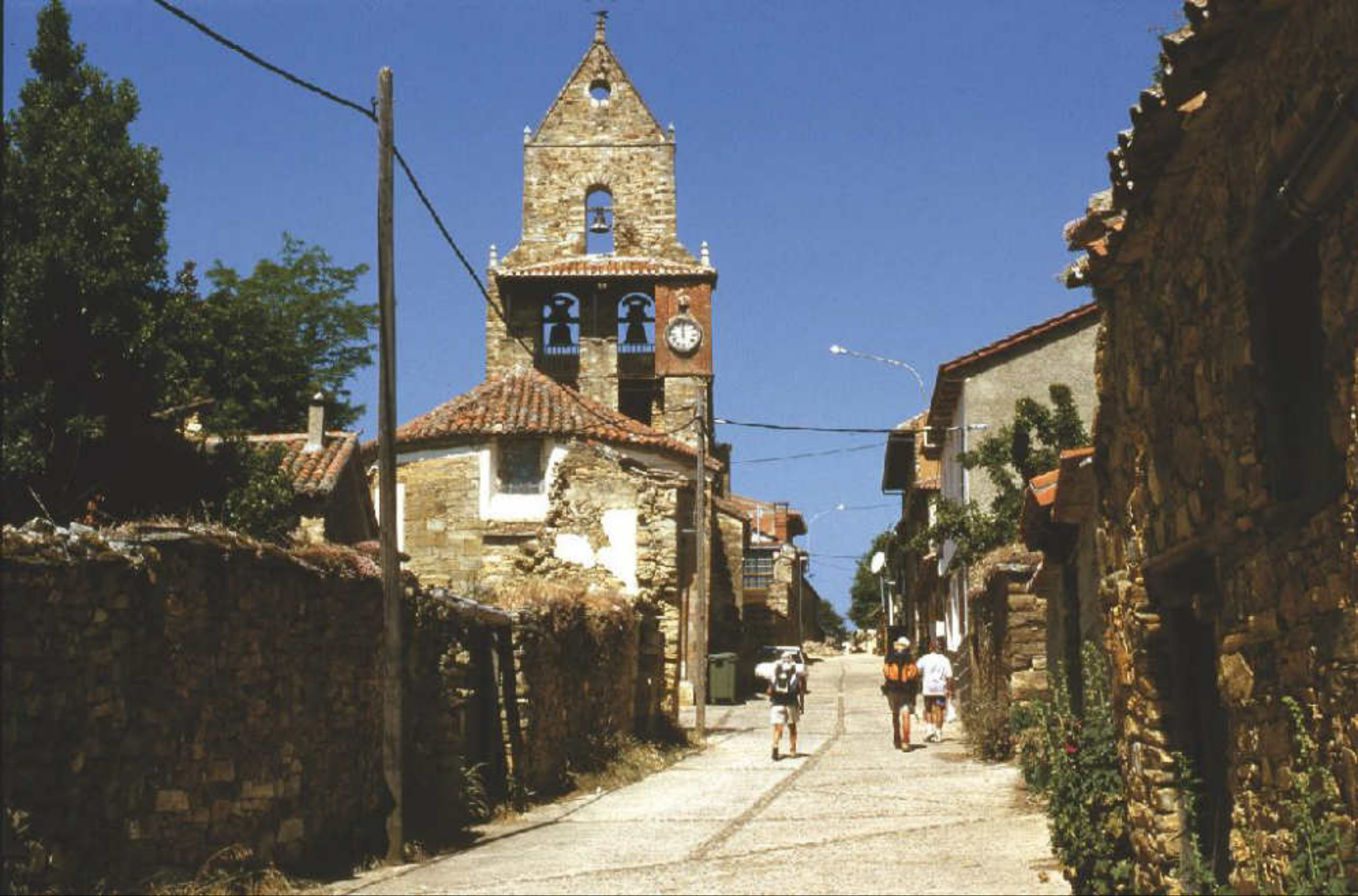
Rabanal del Camino. Calle Real. Antes de la destrucción de la tapia
