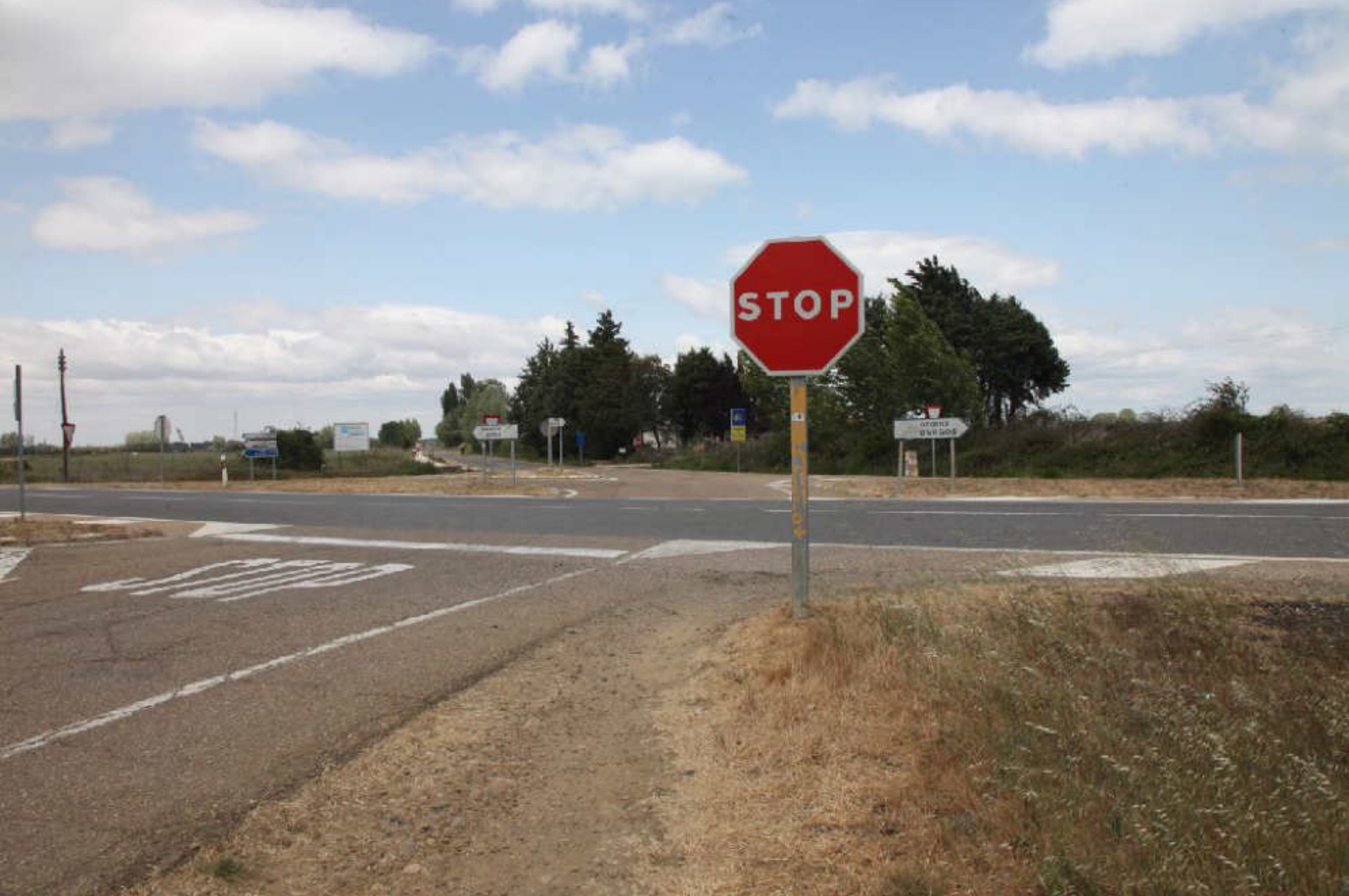
Intersección con N-120 en la salida de Carrión de los Condes
