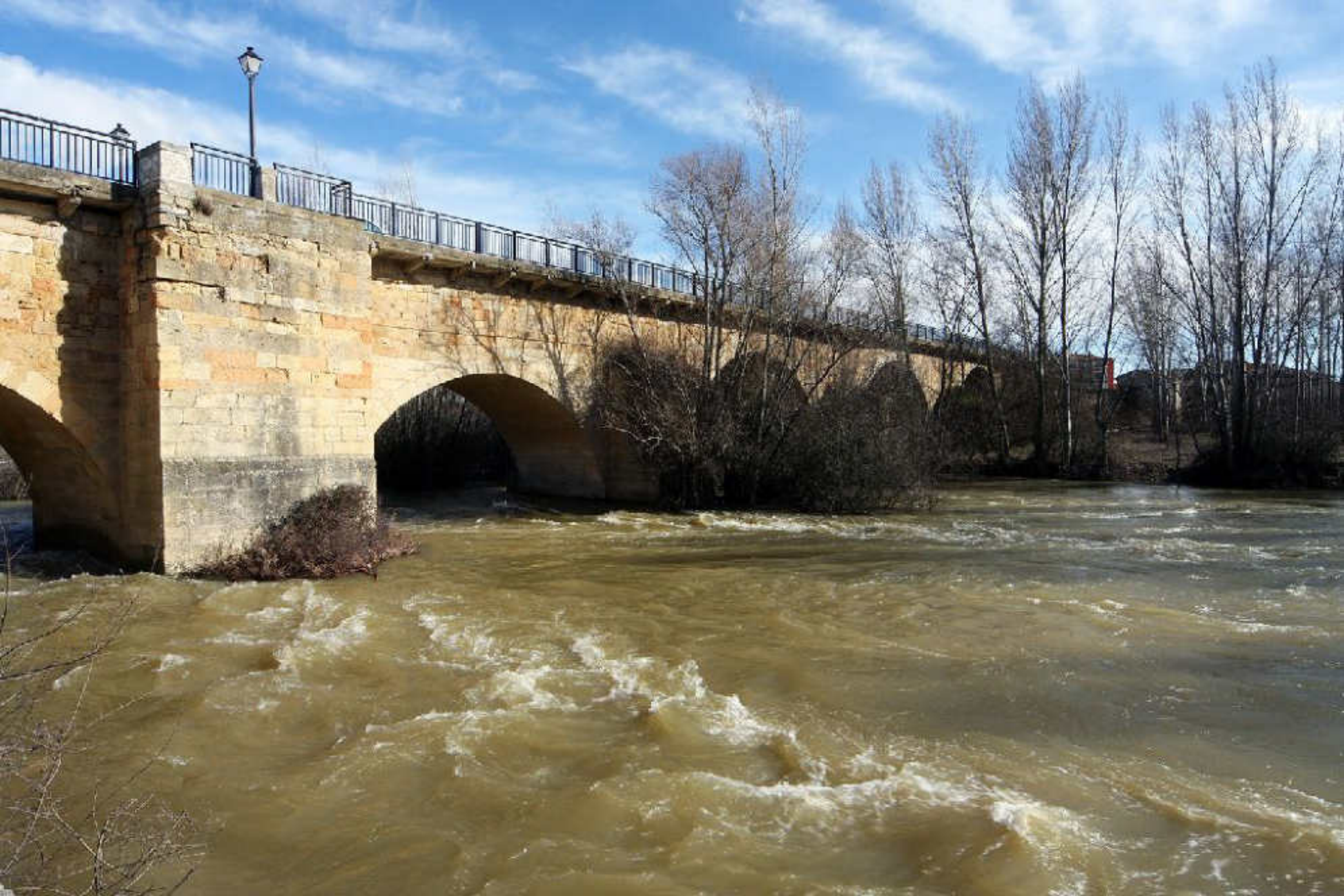
Mansilla de las Mulas. Puente sobre el Esla
