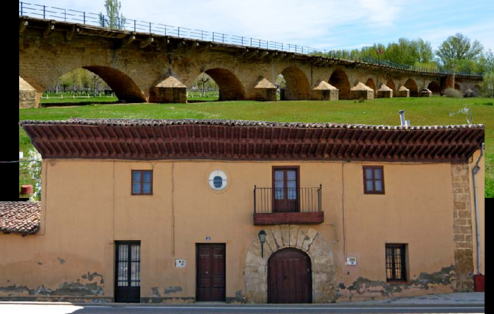
Puente Villarente. Puente y hospital de peregrinos (León)
