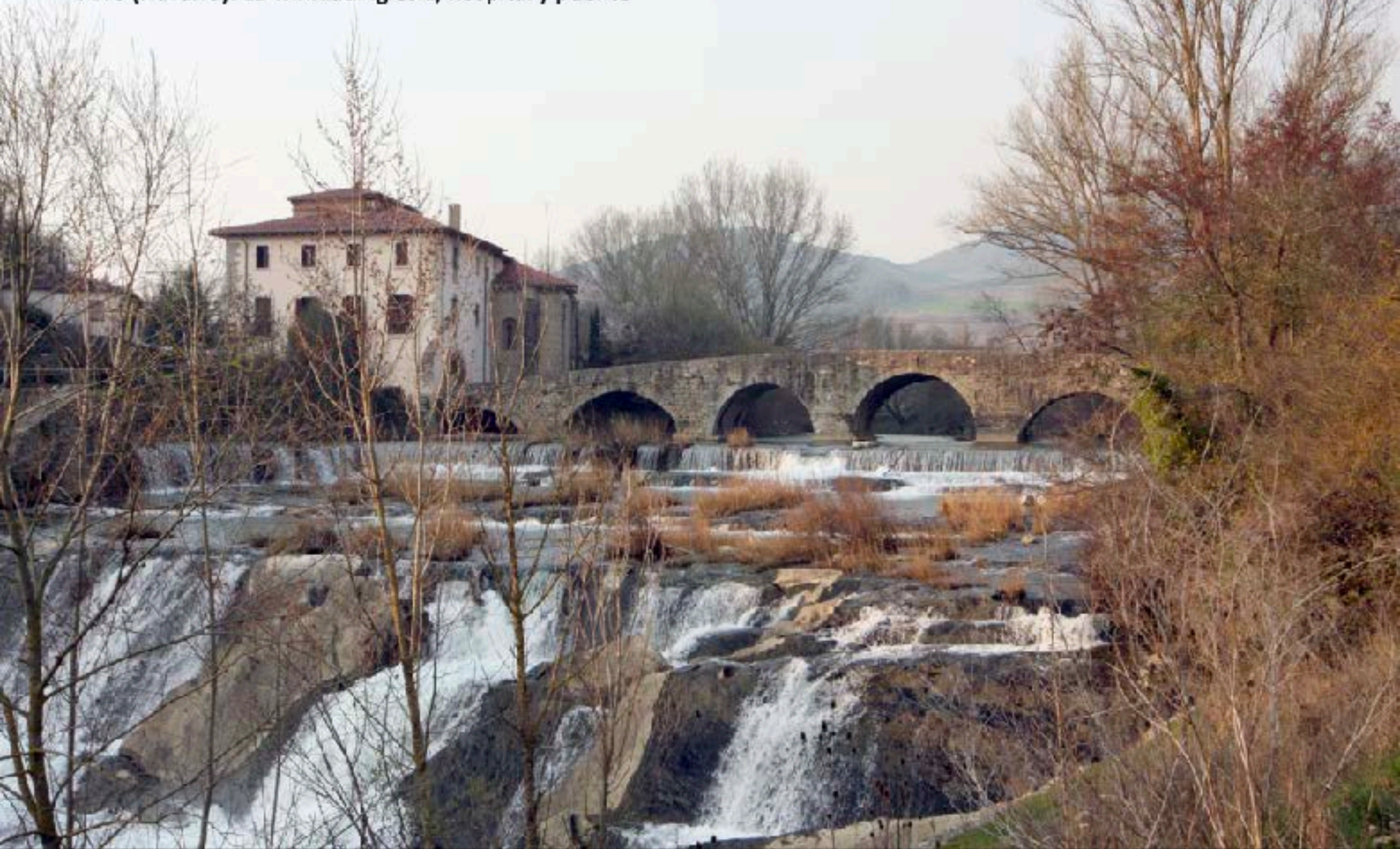
Arre (Navarra). La Trinidad. Iglesia, hospital y puente
